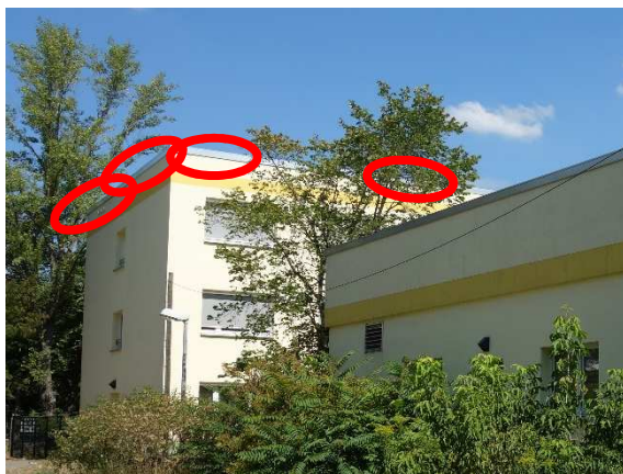
Abb. 3: West- und Südseite Hansastraße 190: Bereiche zur Anbringung von Quartierkästen
