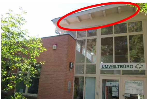
Abb. 1: Westseite Hansastrasse 182a: Bereich zur Anbringung von Quartierkästen
